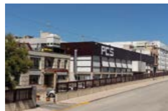
USINE DE PICASSENT
