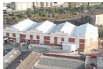
USINE DE MARTORELL
